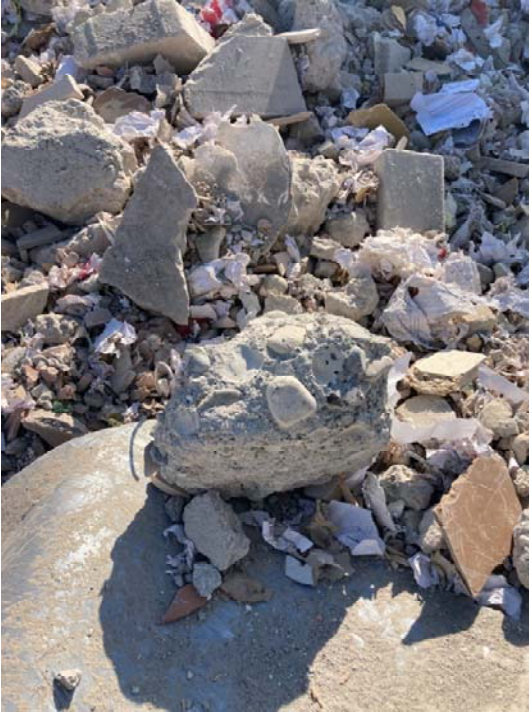
Resim 1: Beton içeriğini gösteren parça 1
