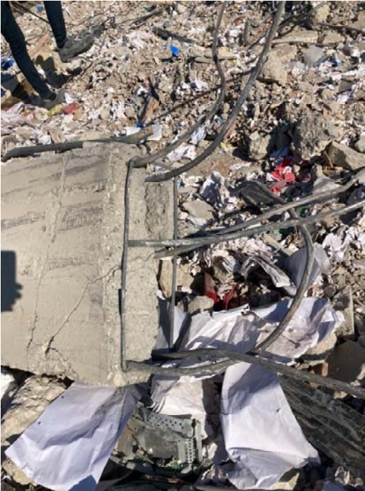
Resim 5: Enkaz alanında bir kolon parçası
