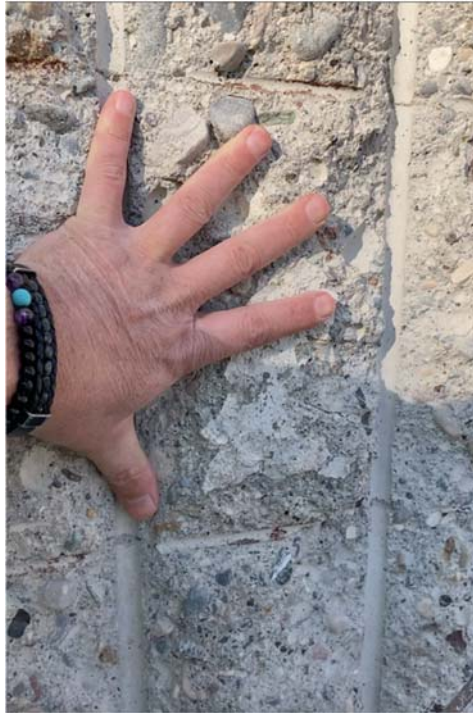
Resim 9: Resim 8'deki kolonun etriye aralığı
