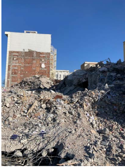
Resim 12: Enkaz alanı ve aynı adada bulunan ve yıkılmayan 7 katlı bina
