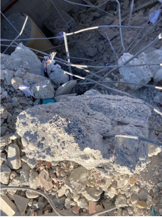
Resim 3: Beton içeriğini gösteren parça 3
