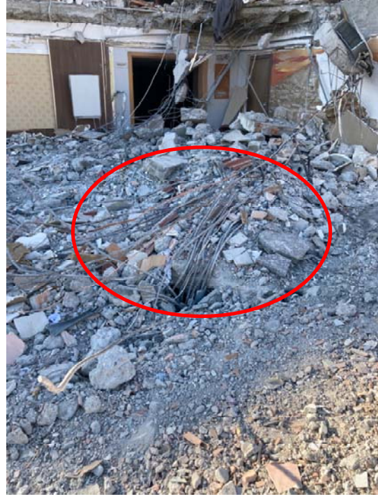
Resim 11: Zemin kat kolon filiz ve donatıları
