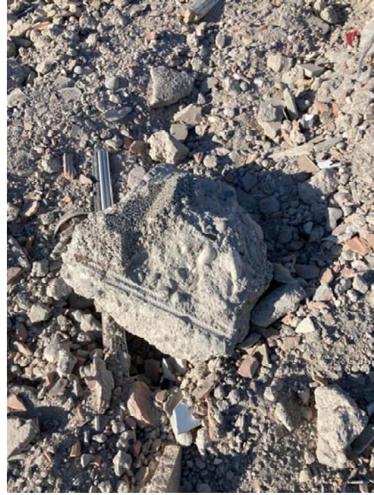
Resim 2: Beton içeriğini gösteren parça 2
