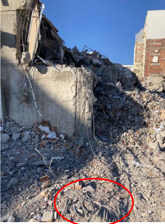
Resim 10: Zemin kattaki kolon filizleri
