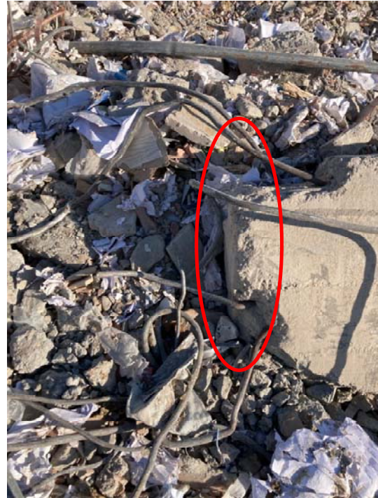
Resim 6: Enkaz alanında bir kolon parçası ucu
